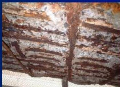
主桁下面の鉄筋腐食
