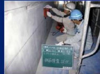
④鉄筋探査工
