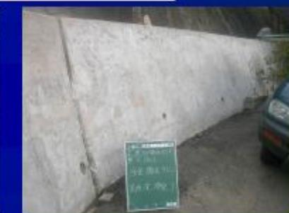
⑦ひび割れ注入工完了
