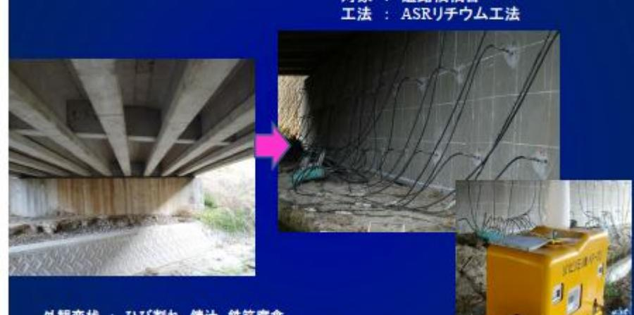
外観変状 : ひび割れ、錆汁、鉄筋腐食
