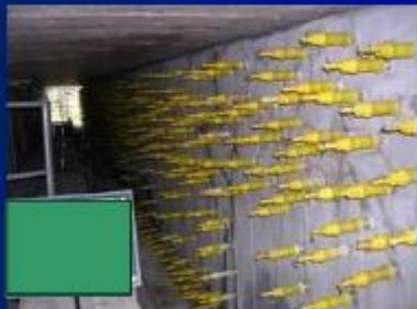
②表面漏出防止(ひび割れ注入)
