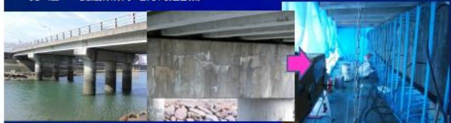
外観変状：橋脚、橋台に亀甲状ひび割れ。
