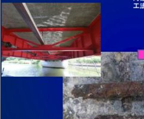
外観変状 : 鉄筋に沿ったひび割れ。一部には錆汁、浮きはく離も見られる。
