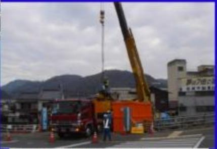
削孔機吊込状況（45tクレーン）
