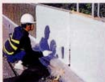
(AR弾性仕上塗材・シーラー (AR-52) 100~150g/m 2 、 AR弾性仕上塗材・上塗 (AR-53) 400g/m 2 X2回ローラー塗布)
