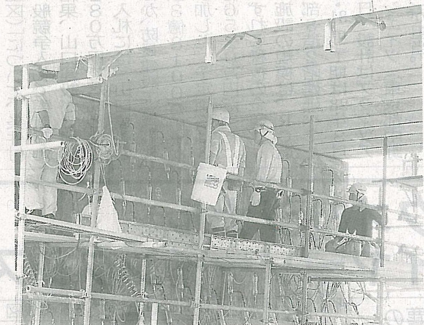
橋脚を間近で見る参加者ら
