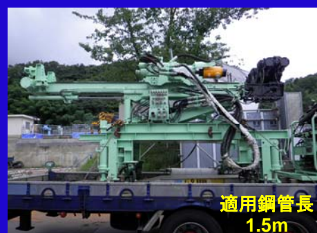
施工機械：スキッド (約3.5t)
