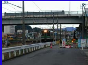
列車通行状況
