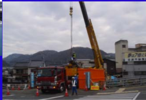
削孔機吊込状況 (45tクレーン)
