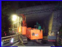
夜間施工状況
