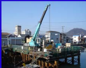
資材吊込状況 (4.9tクレーン)
