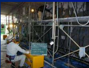
亜硝酸リチウム内部圧入工施工状況
