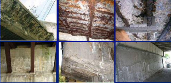
個々の状況に応じて最適な補修技術・補修材料を選定することが重要
