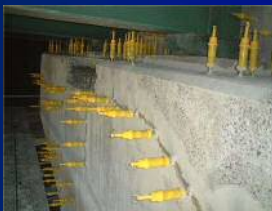
自動低圧注入器による注入状況
