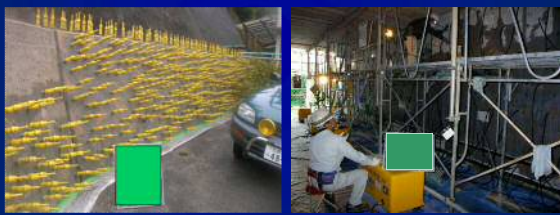
ひび割れ注入工
