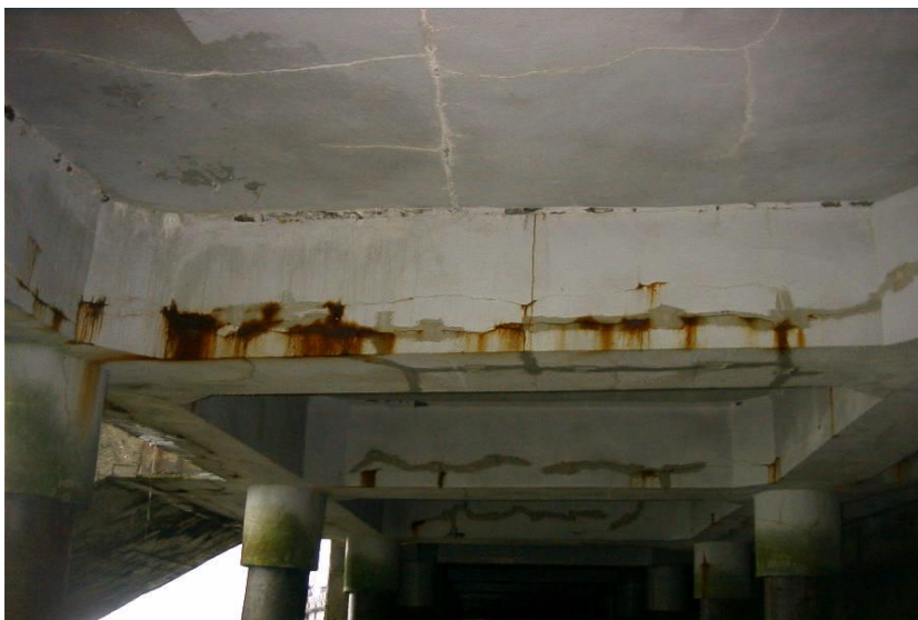
鉄筋腐食を生じているコンクリート構造物の例
