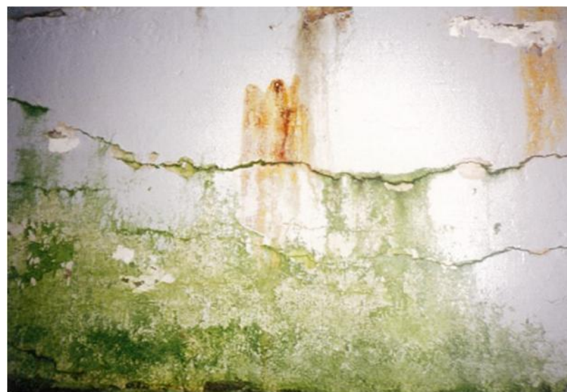
鉄筋腐食を生じているコンクリート構造物の例
