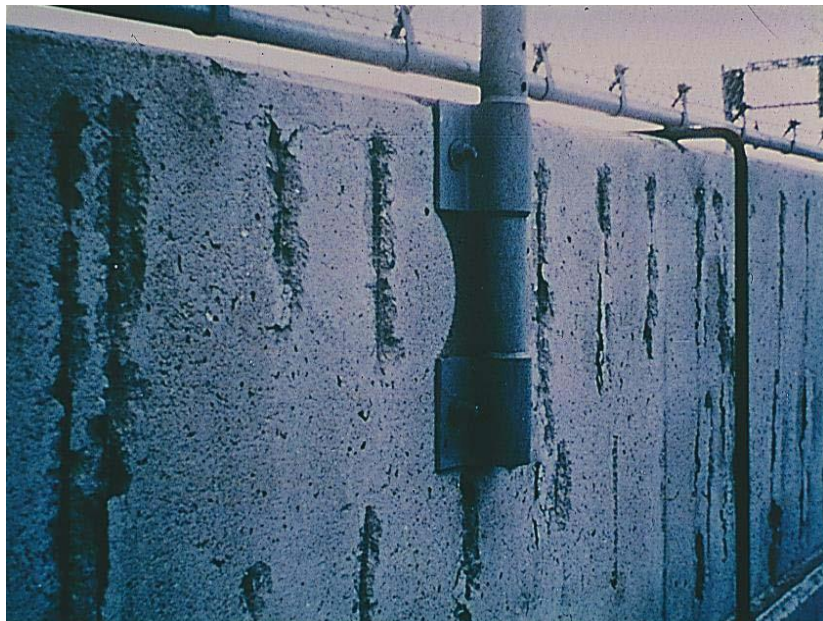
壁高欄のコンクリートはく落
