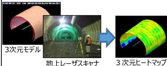
3次元モデルと3次元計測を連携することで、施工エリアの面的管理を実現、施工の実施状況の把握及び出来形管理の効率化を図る
