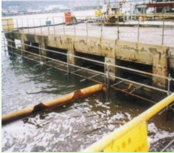
施工前(全体像)
