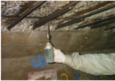
鉄筋新設
