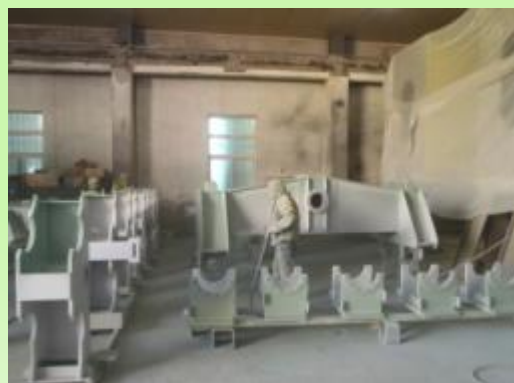
上塗材 塗装状況
