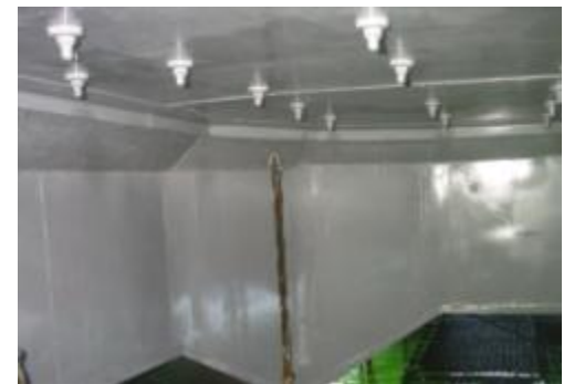
天井部 GFプロテクト施工
