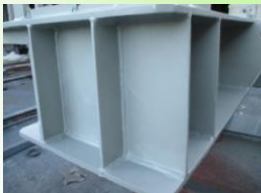
下塗材塗布状況
