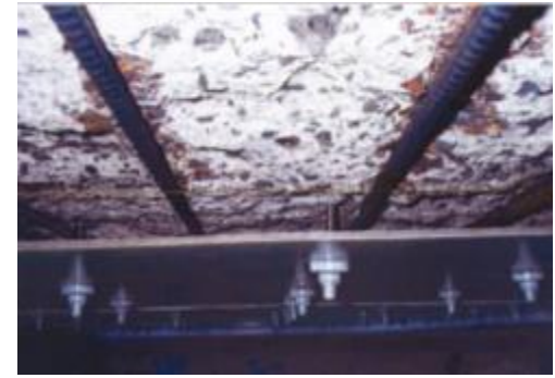
埋込型枠加工取付(GMP板=7mm)
