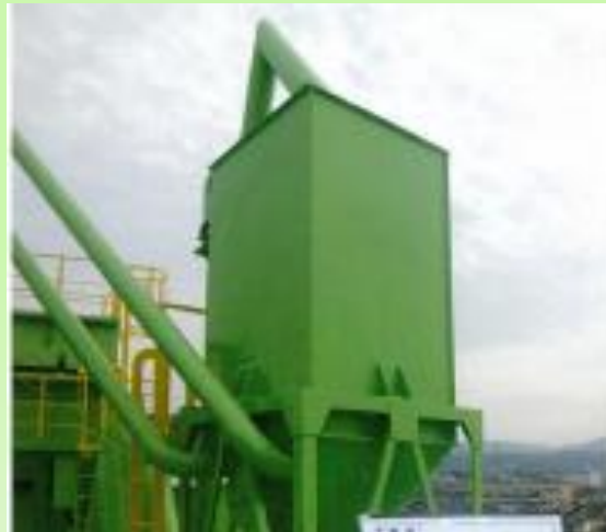
セメントサイロ 施工後
