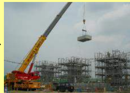
クレーンで設置
