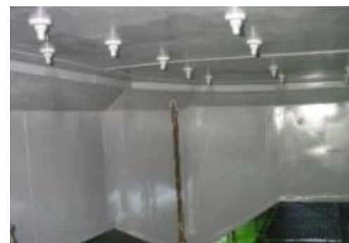
天井部 GFプロテクト施工
