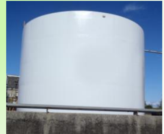
化学工場 施工後
