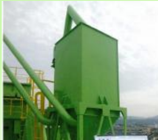
セメントサイロ 施工後
