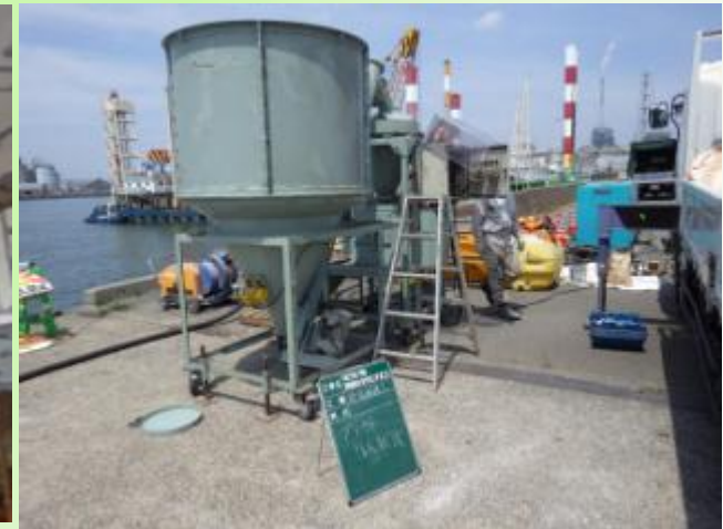
グラウト注入
