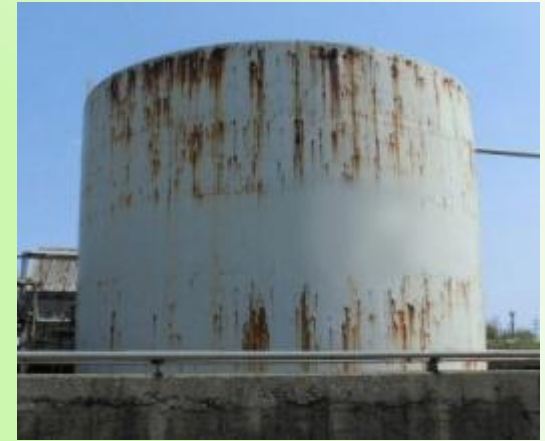
化学工場 施工前
