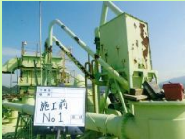
セメントサイロ 施工前
