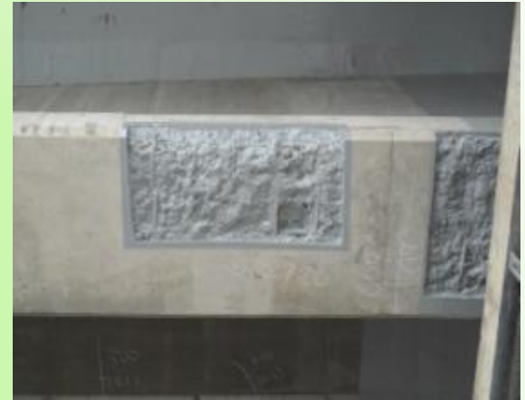
補修箇所拡大
