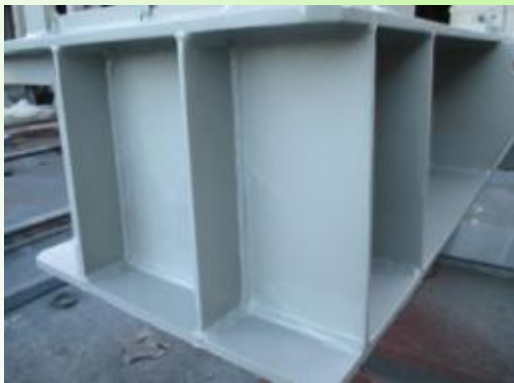
下塗材塗布状況
