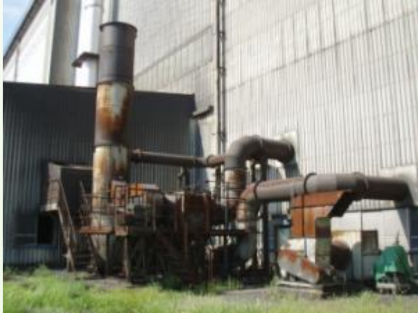
屋外排気設備 施工前
