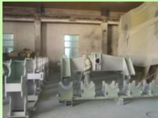
上塗材 塗装状況
