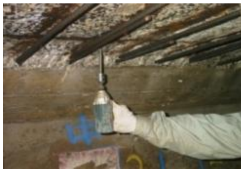
鉄筋新設
