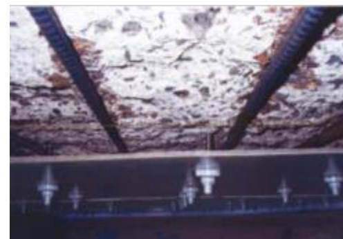
埋込型枠加工取付(GMP板=7mm)
