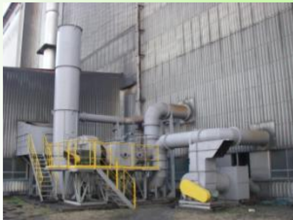
屋外排気設備 施工3年後
