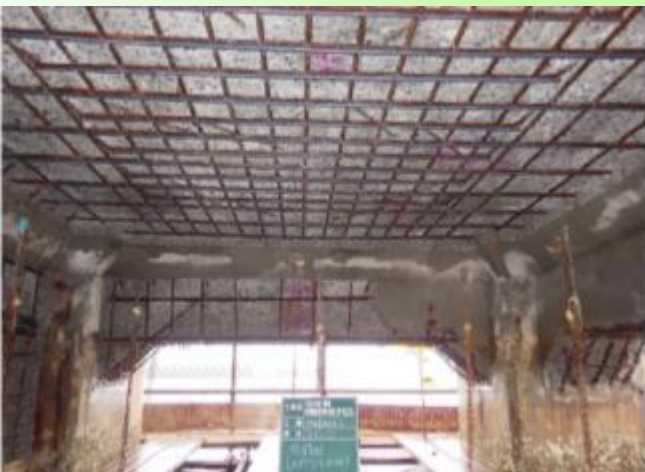
鋼材防錆処理完了
