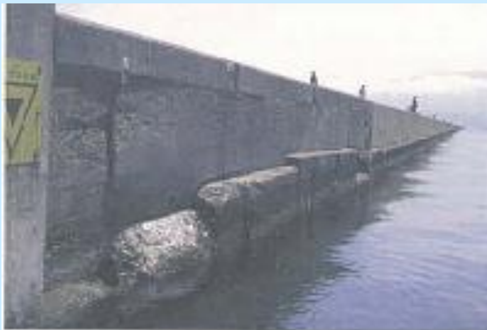
写真-1 明治41年竣工の小樽港北防波堤
