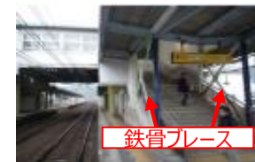
鉄骨ブレースによる駅の耐震補強
