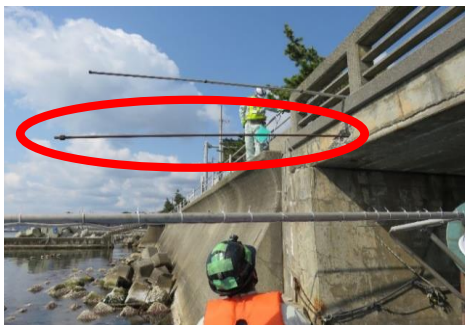
▲PC鋼材の突出事例
