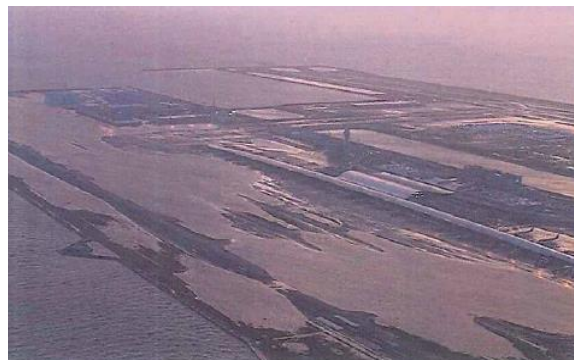
関西国際空港の被災状況 (台風第21号)
