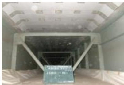
炭素繊維シートの貼り付け
