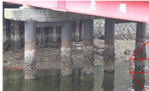
▲杭の水中部 (腐食・断面欠損の例)
