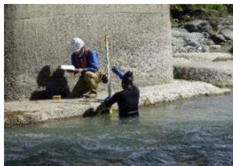
▲潜水土による洗掘調査
