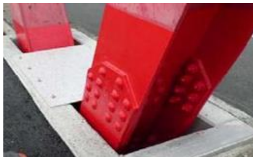
▲破断箇所の修復
