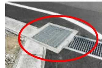
道路上の排水施設
