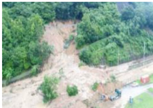
広島呉道路・JR呉線の被災状況 (平成30年7月豪雨)
