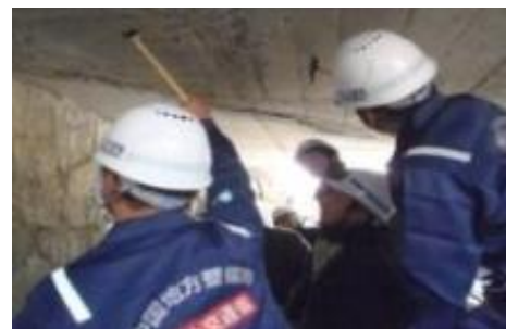
登岐平橋の点検支援 (熊野町) H30.2.8
