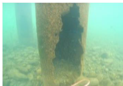
▲パイルベントの断面欠損
