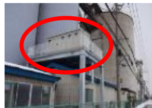
電気系設備の嵩上げ
