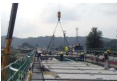
プレキャスト床版による 打ち替え
