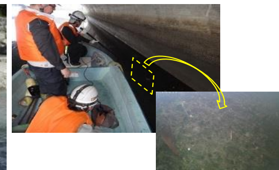
▲水中カメラによる定期点検
