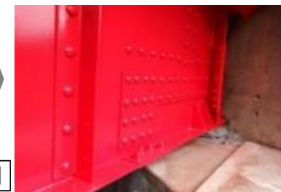
桁端部の当て板・塗装
