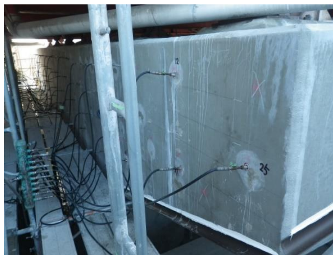
【施工例】 H28年 兵庫県中播磨県民センター「京見橋」
