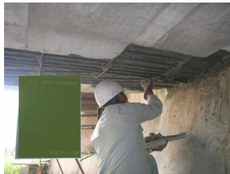
剥離部を部分断面修復
