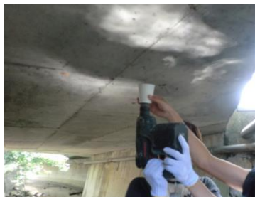
コンクリート粉末の採取状況
