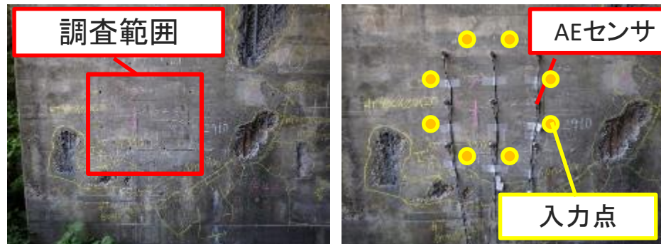
図- センサ設置状況
