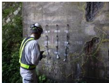
図- ドリル削孔状況
