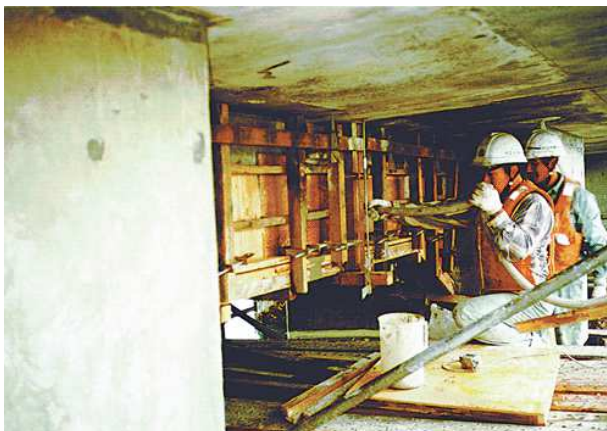
【側面充てんの施工】
