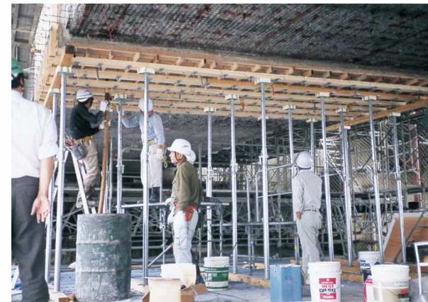
【下面充てんの施工】
