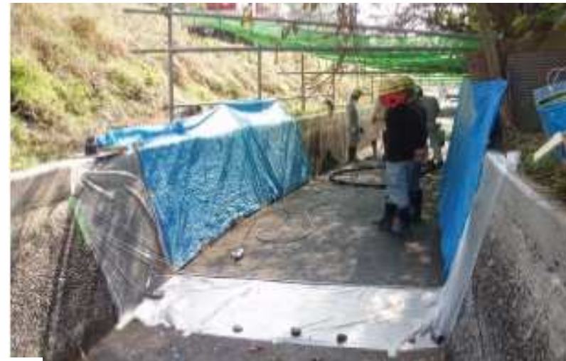
〔シート養生状況〕
