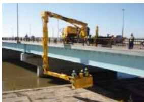
橋梁点検車による点検
