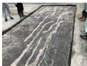
地震による床版のひび割れ損傷
