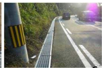
側溝蓋の設置
