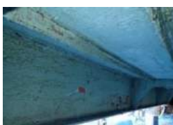
桁の塗装劣化やさびの発生
