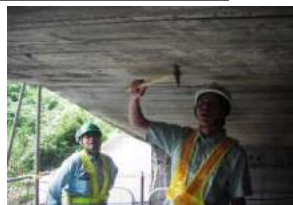
目視及びハンマーによる打音検査
