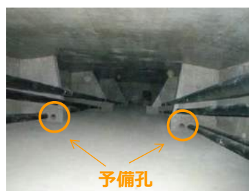
新設橋にて、ケーブル交換・追加用の予備孔を設置
