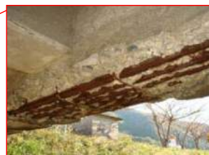
主桁の剥離、鉄筋露出
