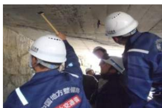
登岐平橋の点検支援 （熊野町）H30.2.8
