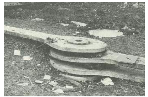
崩壊後のアイバーチェーン
