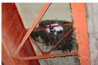
劣化による床版の抜け落ち損傷
