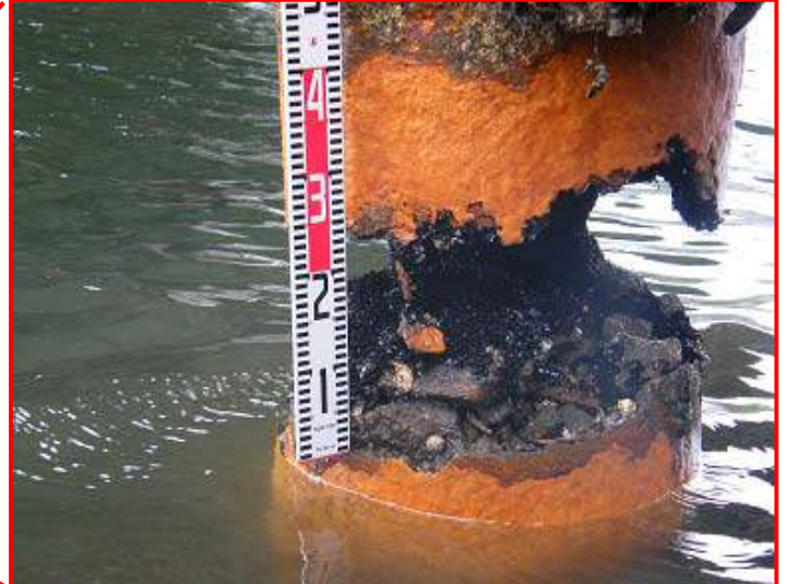
※水中部から調査を実施したところ鋼製杭橋脚に著しい腐食が確認
