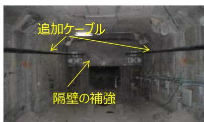
既設橋にて、PC鋼材の腐食発生を受け、PC桁内に外ケーブルを追加配置した例
