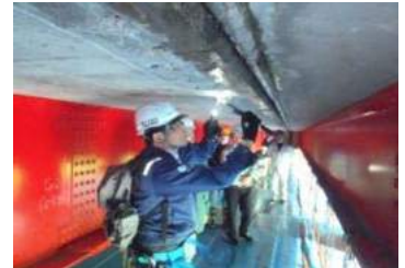
鳥取県管理 射矢谷橋 平成29年11月24日
