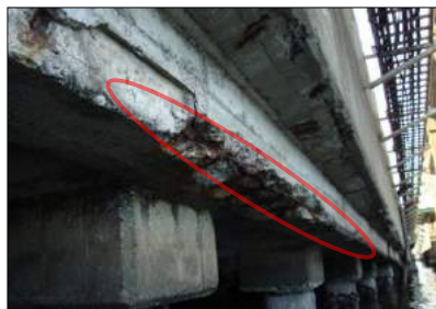
コンクリートの剥離、鉄筋腐食が発生
