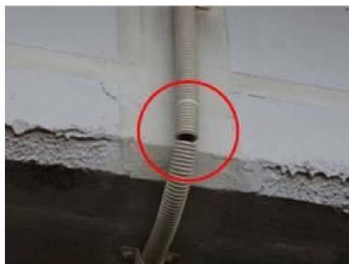
直角曲がり部の割れ
