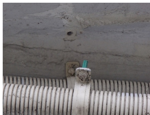
固定サドルの脱落
