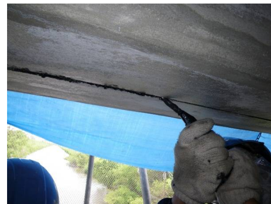
一次陽極(白金チタン)設置
