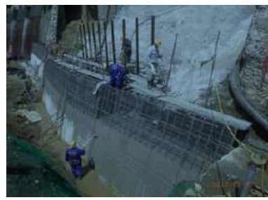
擁壁工 外壁の埋設型枠
