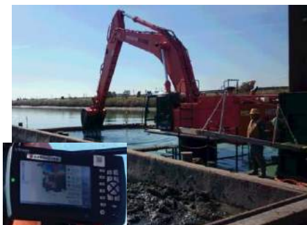
MGバックホウによる浚渫
