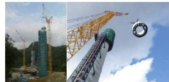
クレーンで吊り込み設置
