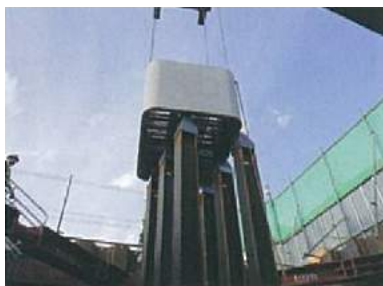
橋梁下部工 橋脚部の埋設型枠
