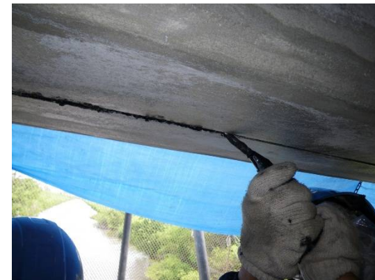
一次陽極(白金チタン)設置
