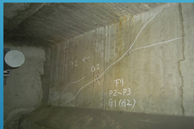
せん断ひび割れが生じたPCT桁
