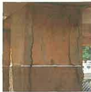
写真5 柱A境界部
