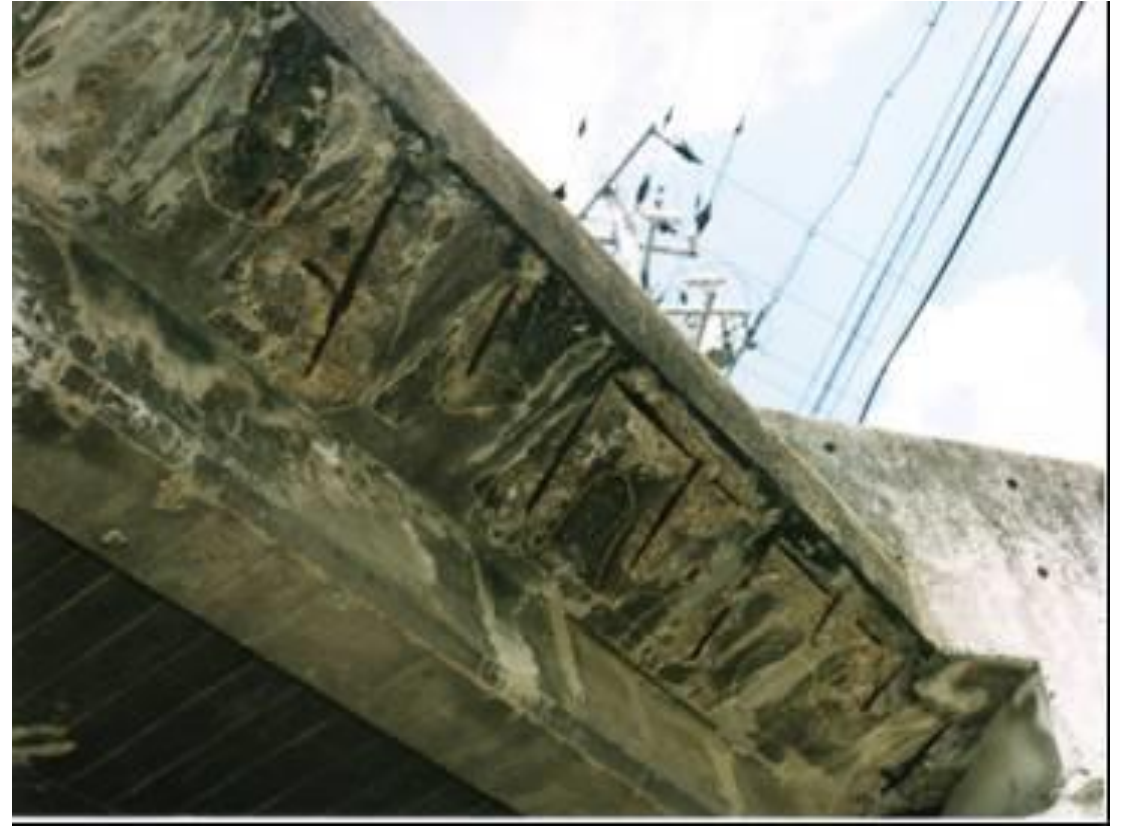
張出し床版下面の鉄筋露出
