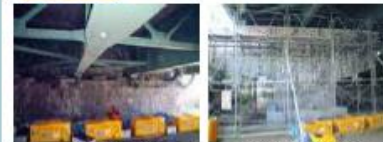
橋台のASR補修事例
