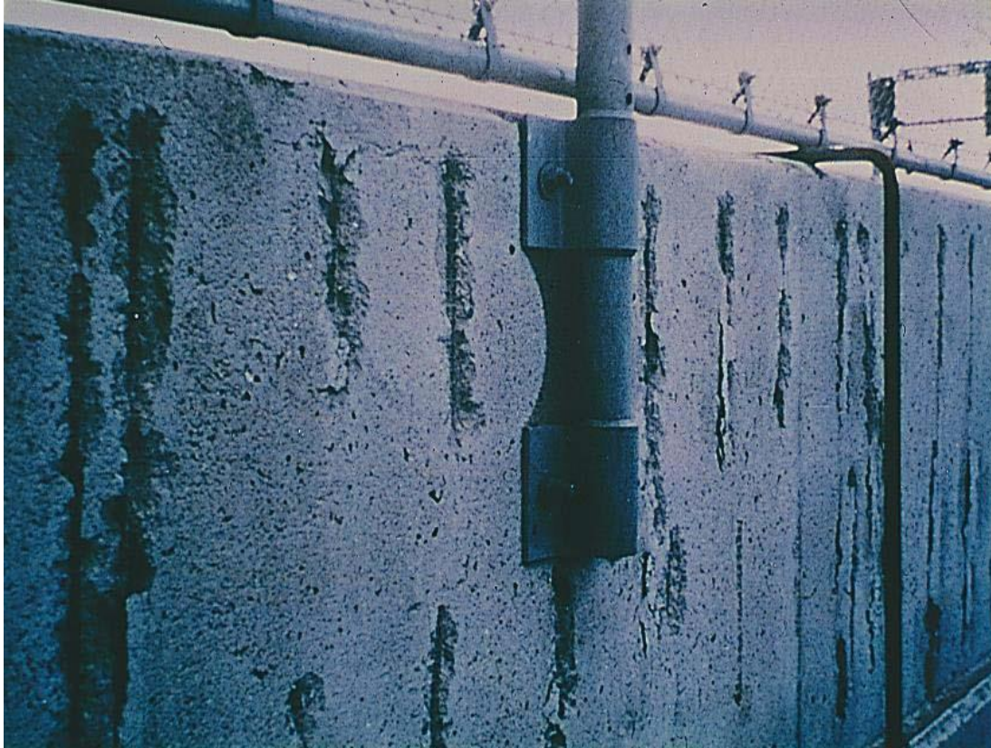
壁高欄のコンクリートはく落
