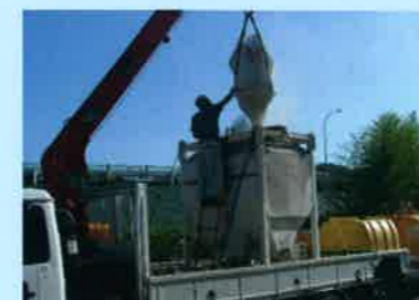
乾式モルタル投入
