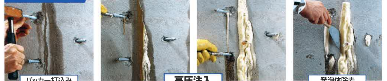
パッカー打込み 高圧注入 発泡体除去
