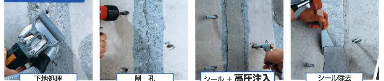
下地処理 削孔 シール + 高圧注入 シール除去
