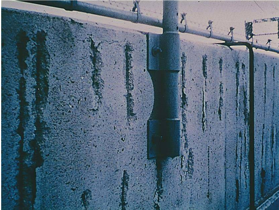
壁高欄のコンクリートはく落
