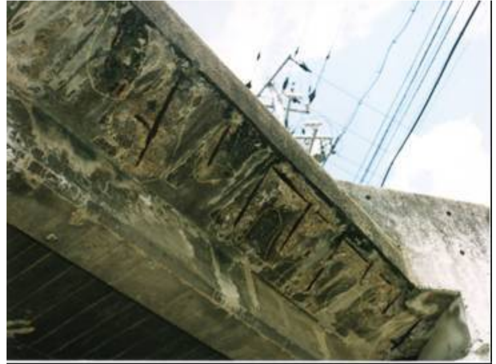
張出し床版下面の鉄筋露出
