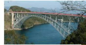
西海橋の橋脚点検
