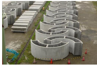
工場から現地に搬入
