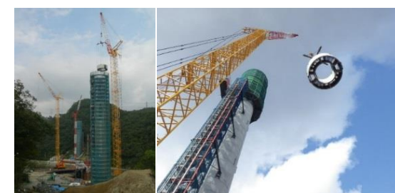
クレーンで吊り込み設置
