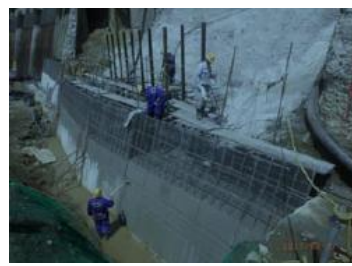
擁壁工 外壁の埋設型枠
