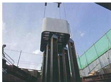
橋梁下部工 橋脚部の埋設型枠
