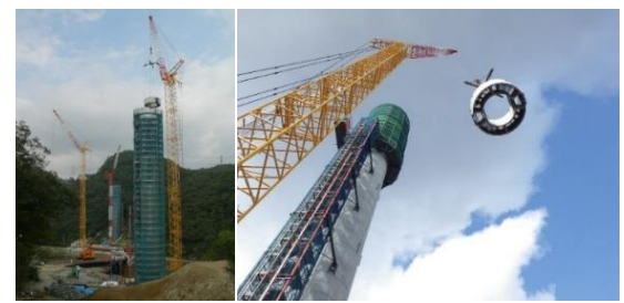
クレーンで吊り込み設置
