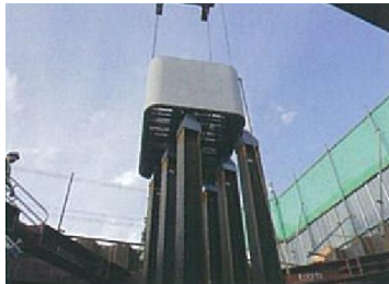
橋梁下部工 橋脚部の埋設型枠
