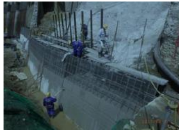
擁壁工 外壁の埋設型枠
