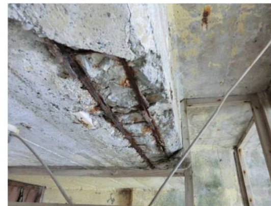
劣化度Ⅳ(梁)
