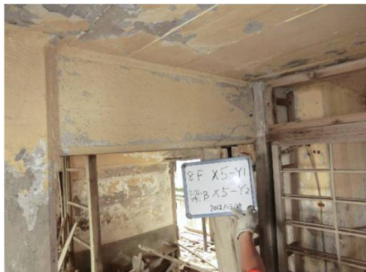
劣化度Ⅰ(梁)
