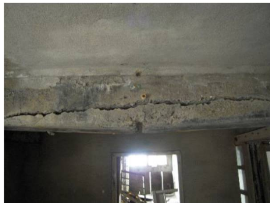
劣化度Ⅲ(梁)
