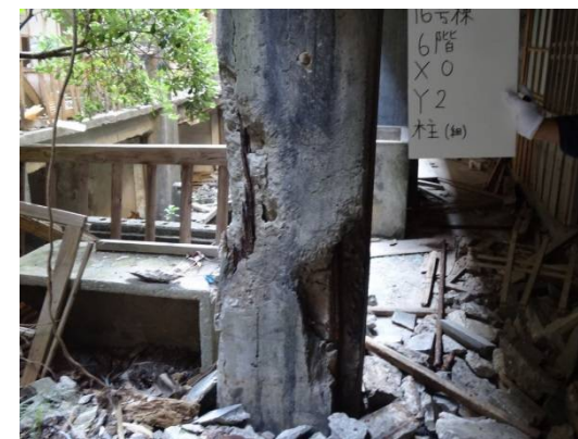
劣化度Ⅴ(柱)
