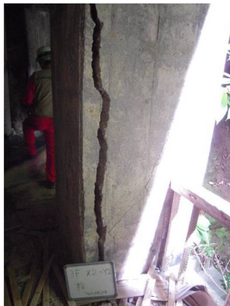
劣化度Ⅲ(柱)
