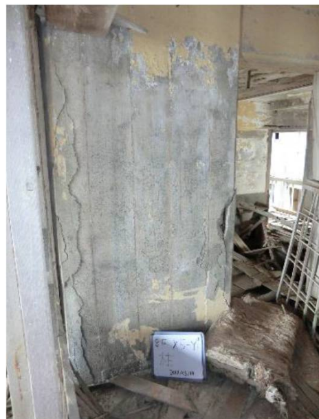
劣化度Ⅱ(柱)
