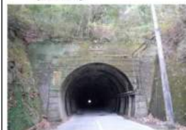
▲松尾隧道（完成後63年経過）
