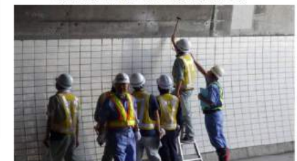
現地実習状況 (H28トンネル初級)
