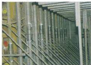
地下構造物施工例
