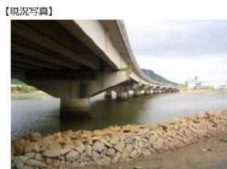
▲屋島大橋（完成後32年経過）
