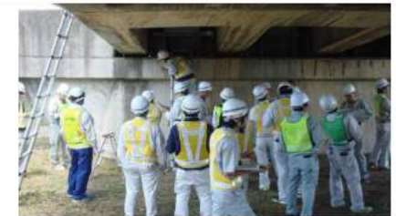
現地実習状況 (H28橋梁初級Ⅰ)
