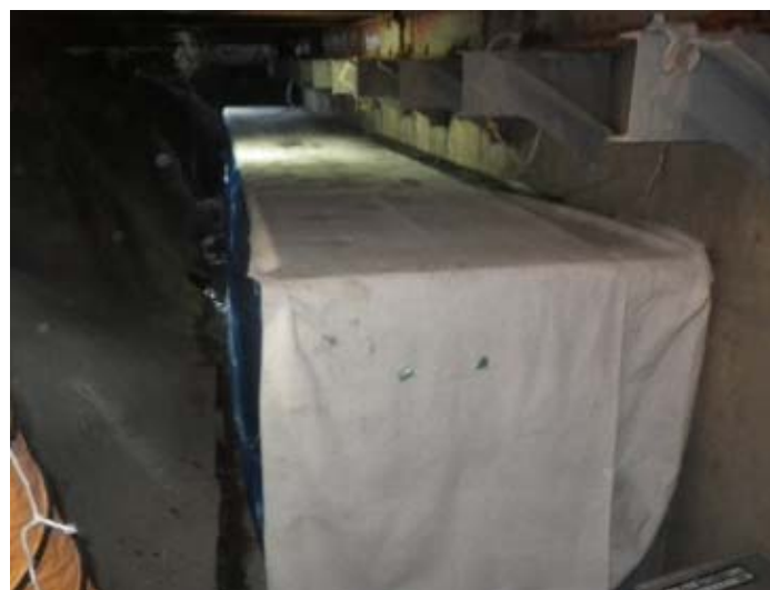
【増フーチングコンクリート養生状況】
