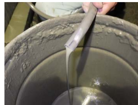
【グラウト排出確認】
