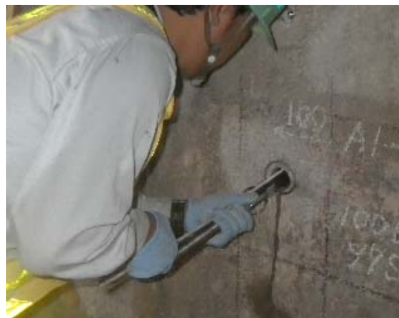
【緊張材の挿入】
