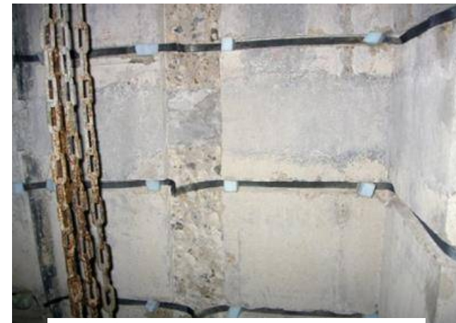
コンクリート表面に溝を切削し陽極を埋設する方式
