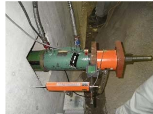
【緊張ジャッキ および計測機器】
