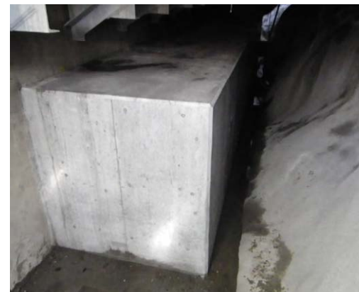
増しフーチング完了後
