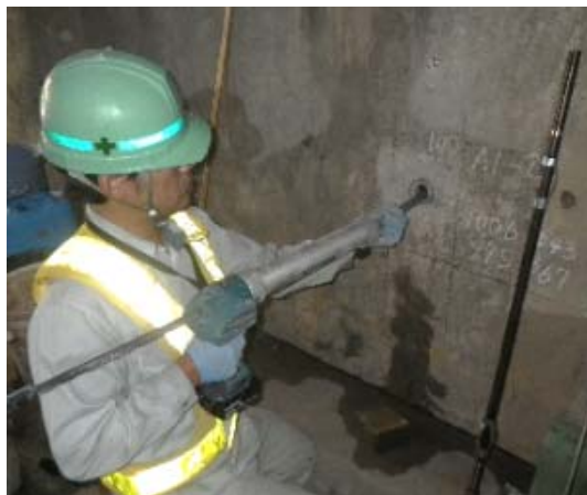
【先端部充填材注入状況】
