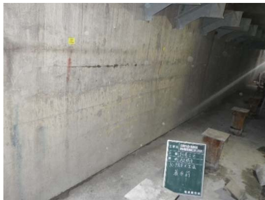
増しフーチング着手前 (増し杭完了)
