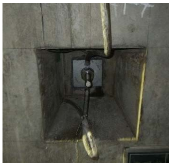
【PCグラウト注入状況】
