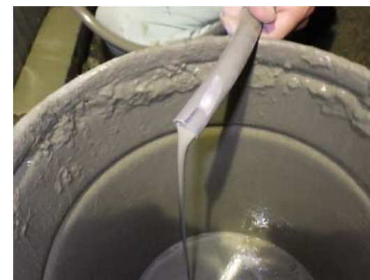
【グラウト排出確認】
