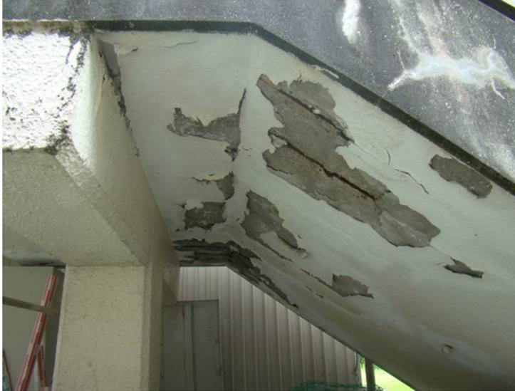
R C階段でコンクリートを打設する際は、底面・上面・側面を型枠で囲って上部から数回に分けて流し込む。施工上、スペーサーが入れにくい為、下部の鉄筋がコンクリートの重さで下方にズレやすく、かぶり厚も薄くなりやすい。また、軒天は水分がたまりやすい為、透湿性の高い仕上げ（リシン仕上げなど）が多く、他の部位より中性化しやすく水分の影響を受けやすい部位と言える。
