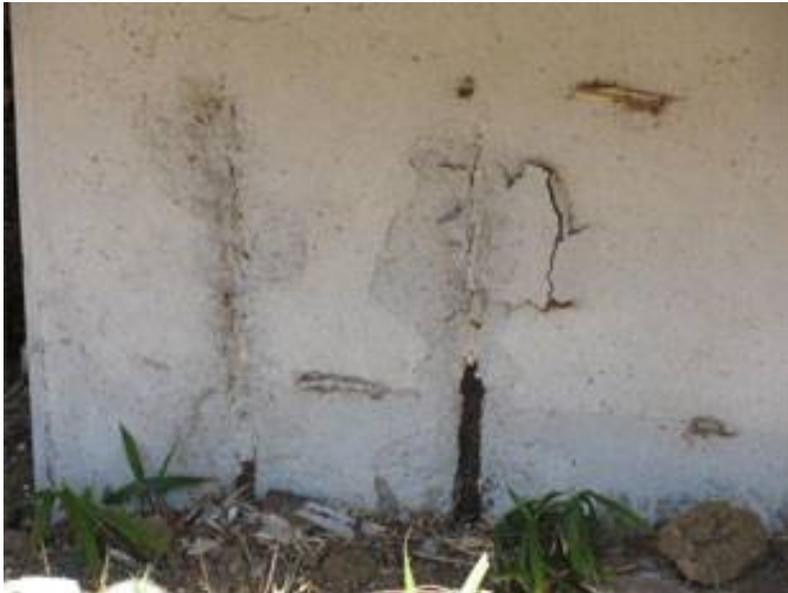
地中梁から上に延ばした鉄筋がコンクリート打設時に、外側へ押される場合あり。その場合、かぶり厚が薄くなりやすい。また、基礎部は打ち放しや軽微な塗装のケースが多く、水分の影響が大きい。
