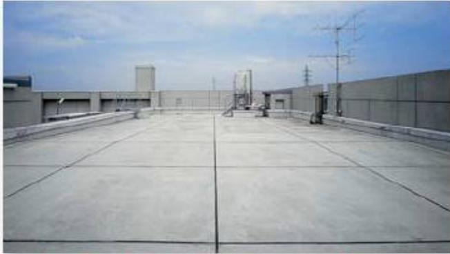
アスファルト防水押えコンクリート仕上げ
