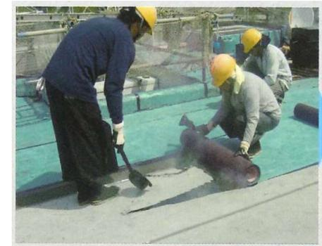
耐久性・柔軟性を向上させた「改質アスファルト」をルーフィングおよび貼付用アスファルトに採用し、防水層全体の耐久性向上。従来、露出仕様で用いられる砂付仕上げではなく、特殊処理繊維面材に遮熱塗料を塗布することで**繊維補強塗膜**が形成され、高反射機能が長期間保持。貼付アスファルトは**低煙・低臭タイプ**の改質アスファルトで環境対応型改質アスファルト熱工法。
