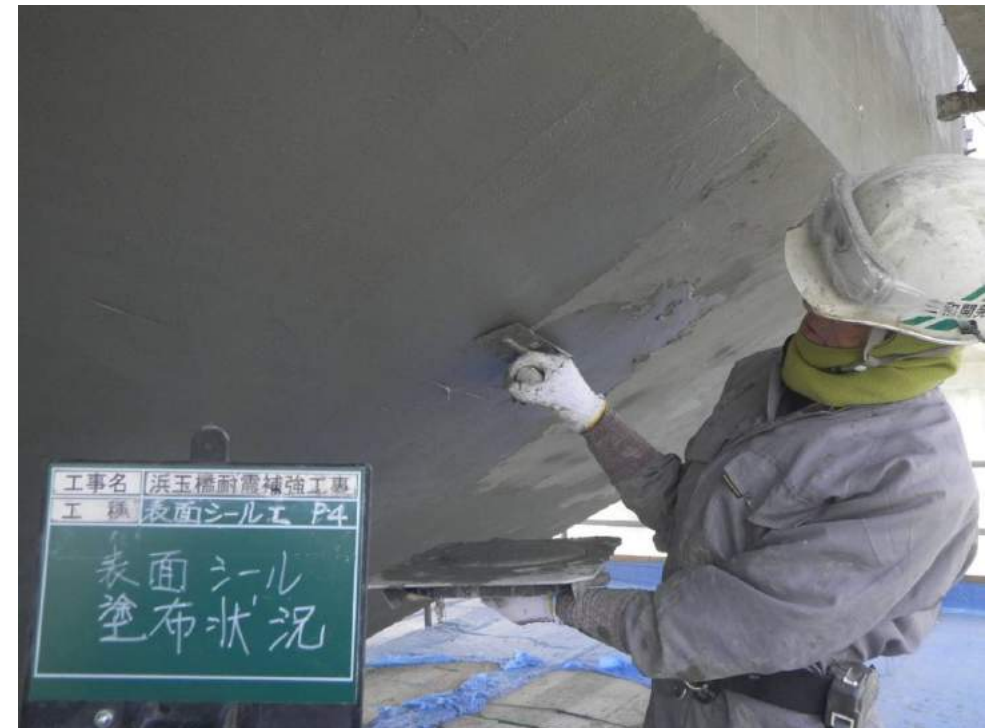
②表面漏出防止(表面シール)
