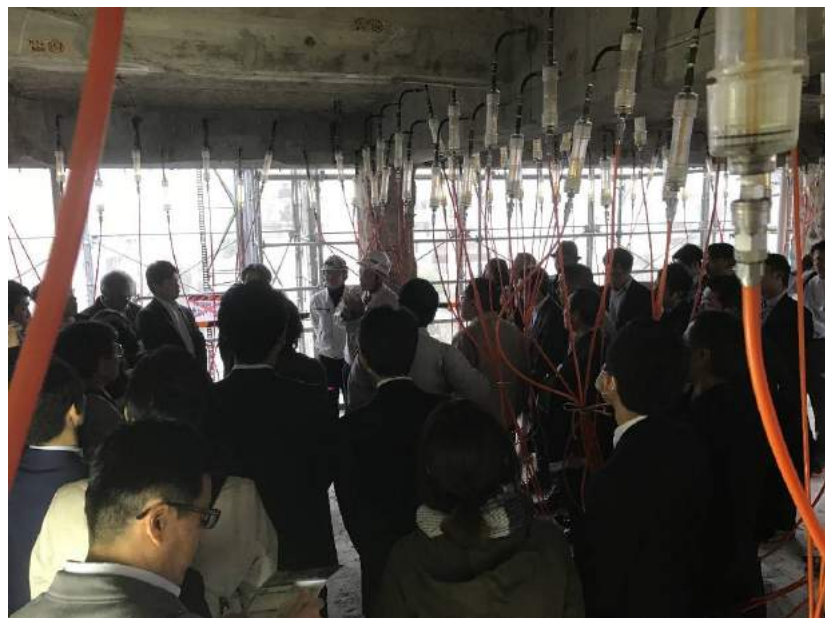
林マンション リファイニング工事 解体現場見学会（2017年10月16日）
