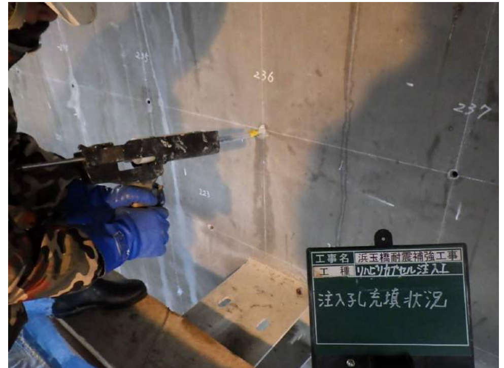
⑧圧入孔充填工
