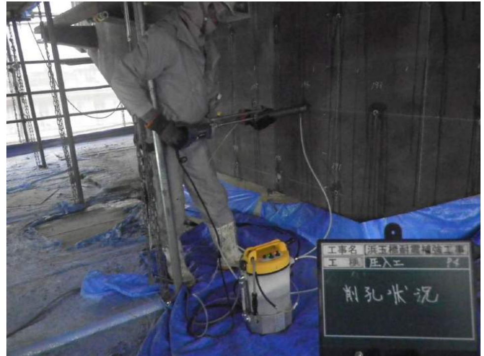
④圧入孔削孔
