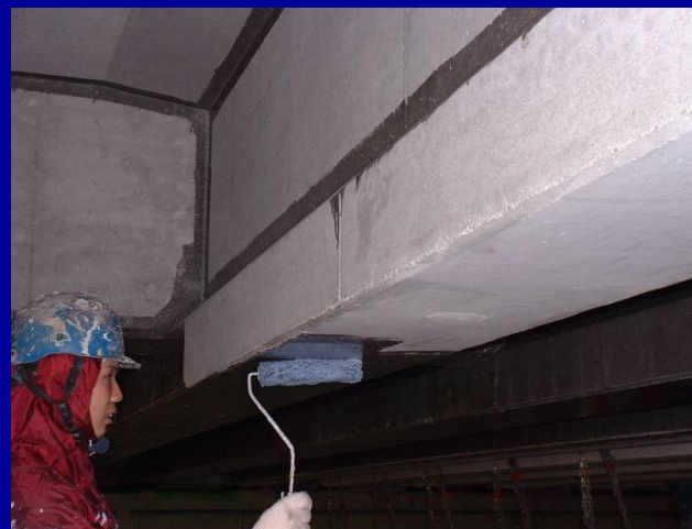
①プライマーの塗装
