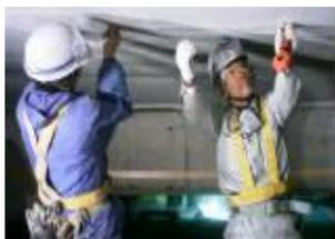
FRPトレイ、照合電極、排流測定端子取付位置をマーキングします。
