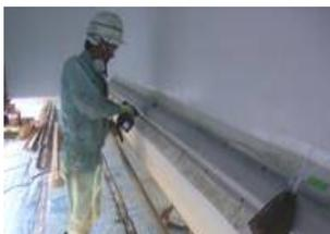
陽極ユニットをチタンビスを用いてコンクリート表面に設置します。
