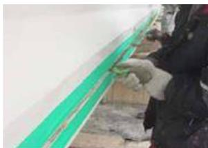
リボンメッシュ電極を溝内に設置し、表面を専用の材料で被覆後、通電のためのケーブルを接続します。
