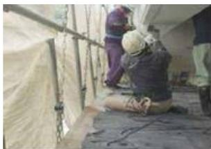
取付位置をマーキング後、所定の位置に電極を入れるための溝をサンダー等により形成します。
