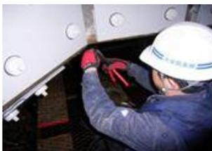
亜鉛シートに付属するケーブル同士を結線し、モニタリング装置まで引き込みます。
