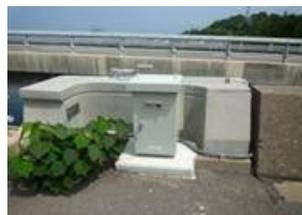
所定の位置にコンクリート基礎を設け、直流電源装置を設置します。
