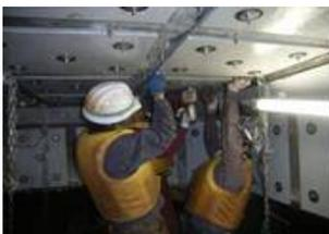
アンカーボルトにより、亜鉛シートを取り付け、固定します。
