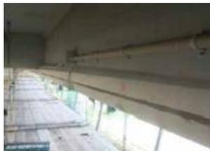
電極及び対象鋼材と接続させたケーブルを直流電源装置まで引き込み接続します。
