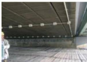
通電用のケーブルを設置後、電極及び対象鋼材と接続したケーブルを直流電源装置まで引き込み接続します。
