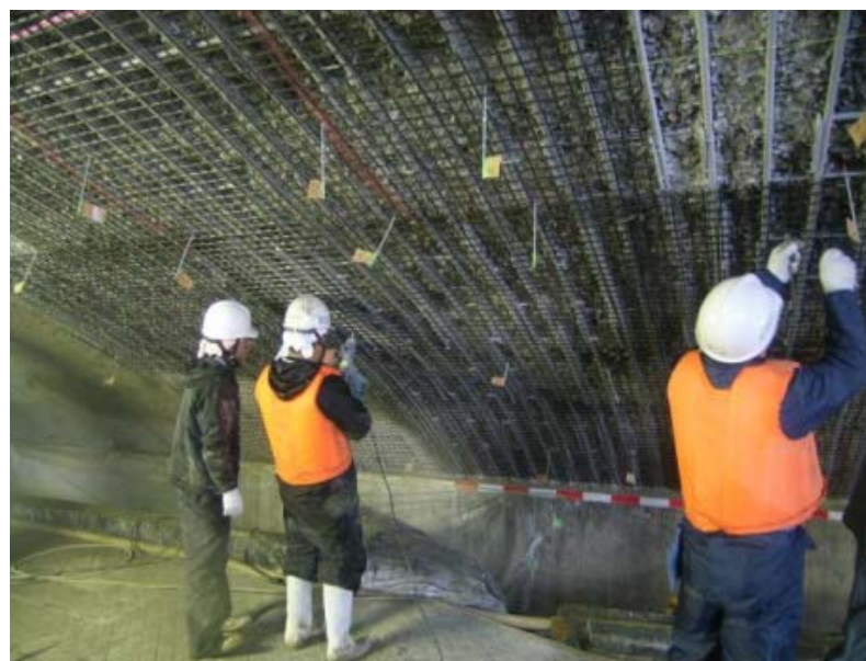
FRPグリッド設置
