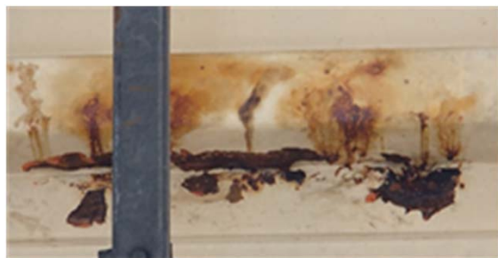
デッキプレート下面の著しい局所腐食部
