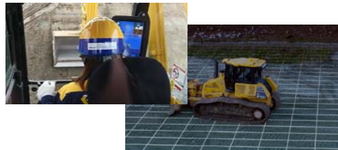
ICT建機による施工
