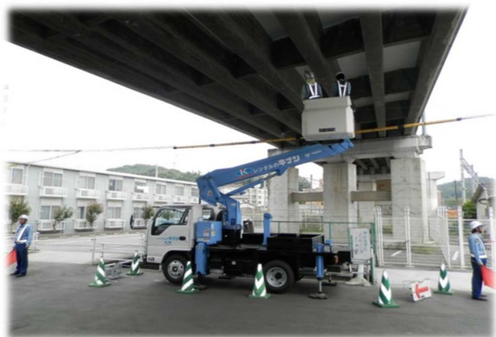
橋梁を定期的に点検し損傷状況を把握
