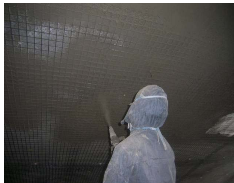
ポリマーセメントモルタル吹きつけ
