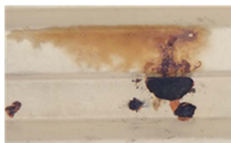
デッキプレート下面の著しい局所腐食部
