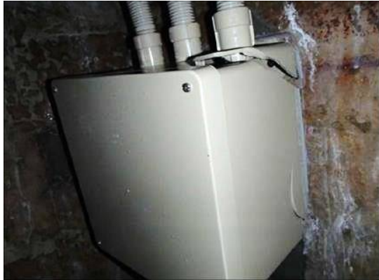
流木が衝突しプルボックス破損
