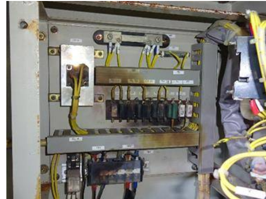
落雷による過大電流で電子部品焼損
