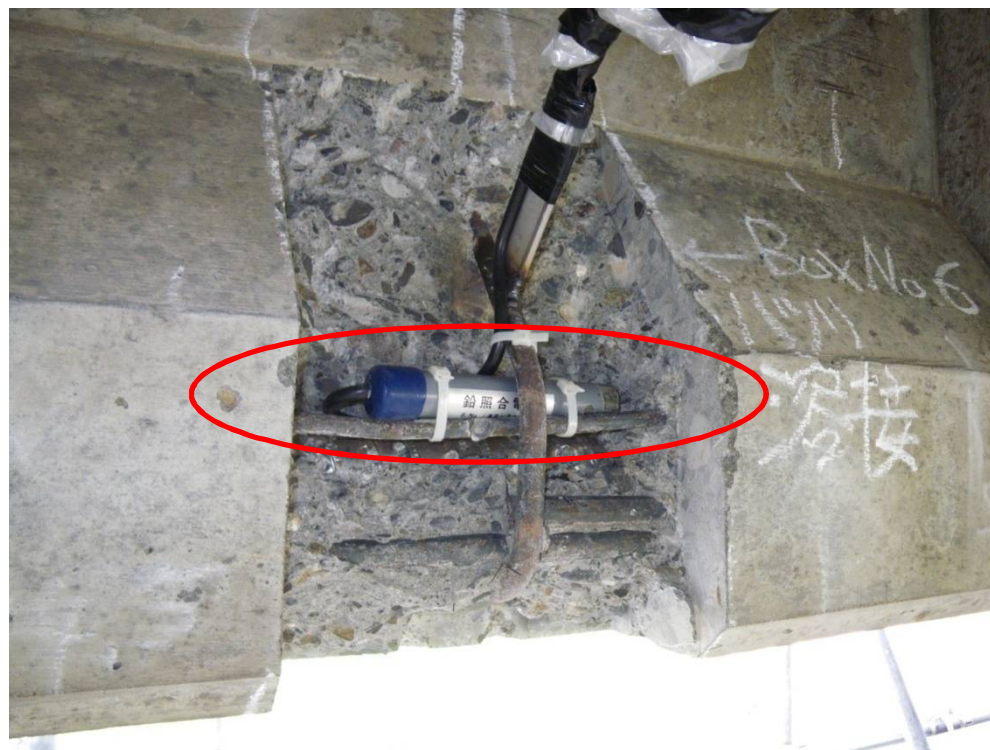
鉛照合電極の設置例
