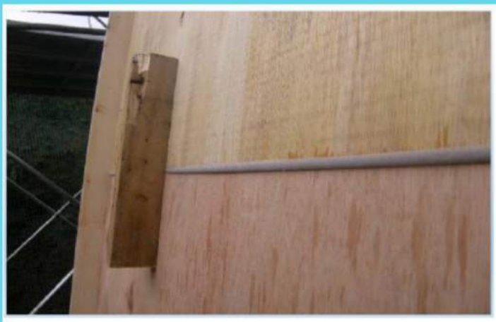
型枠目地は隙間テープで塞いだ
