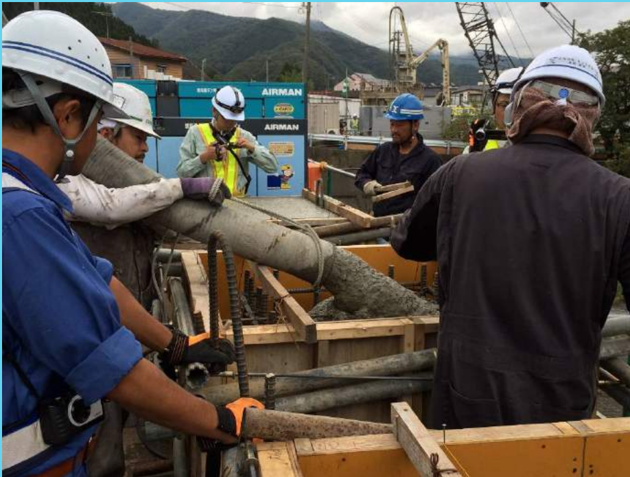
タイプ①丁寧施工・タイプ②標準施工の 寝かせ打ちの状況
