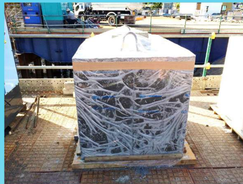
■農業用ビニールシートで養生した翌日の状況
