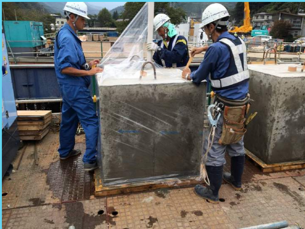
◆農業用ビニールシートで養生
