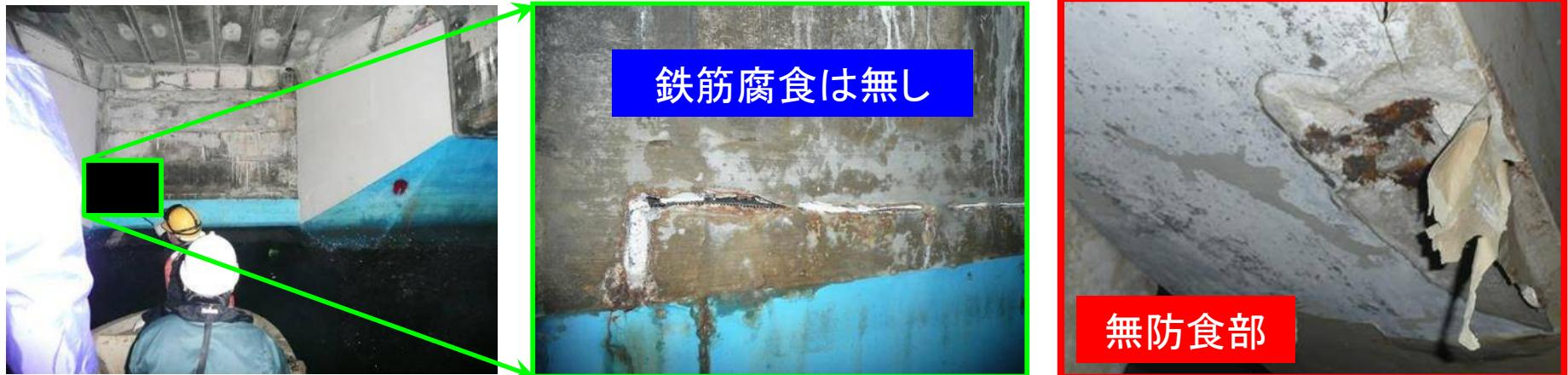
**原因** 外電不溶性陽極による電気化学反応:  $H_2O \rightarrow 1/2O_2 \uparrow + 2H^+ + 2e^-$
