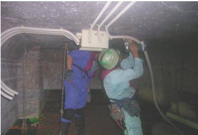
コンダクターバーとリード線をプルボックス内で結線し、直流電源装置まで配線配管を行う。
