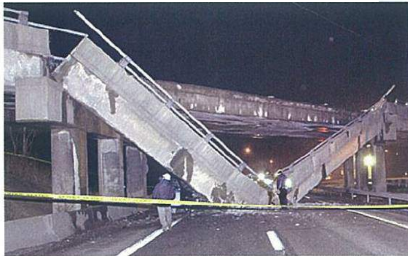
▲ペンシルベニア州 跨道橋の落橋 ・・・凍結防止剤の散布による鉄筋腐食(2005)
