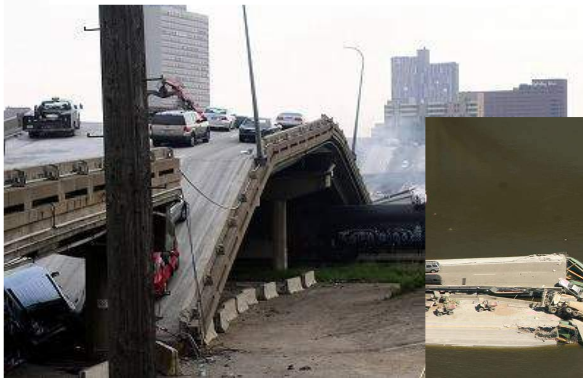
(I-35W) 鋼トラス橋崩壊の状況
