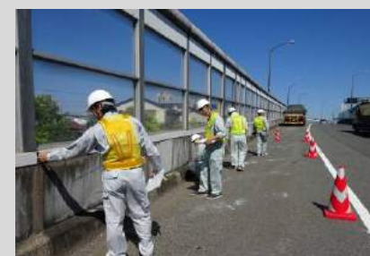
橋面の損傷状況の確認
