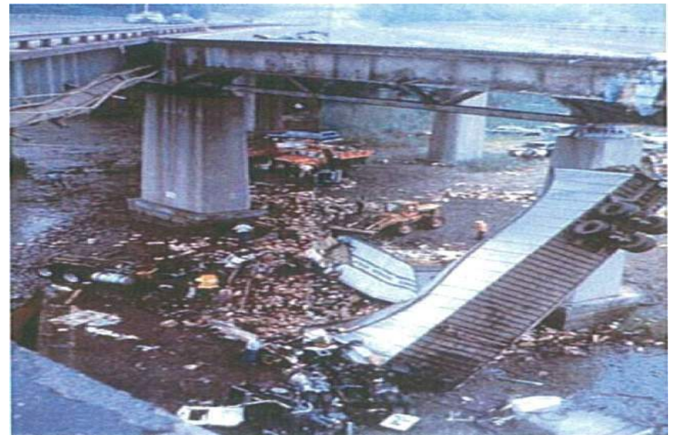
▲コネチカット州 マイアナス橋の落橋 (1983)
