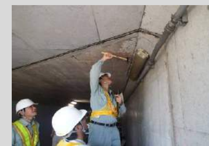
打音点検の様子(函渠)
