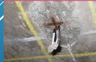
④配線取り外し
