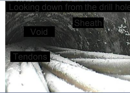
削孔+CCD 充填不良
