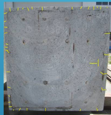
切断面の状況
