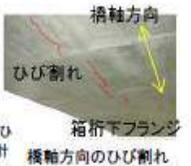
(例) 特殊な形状のPCボスチン桁の一部でひび割れが確認されたことを踏まえ、設計基準でひび割れ防止対策を充実
