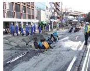
埋設管の老朽化に伴う道路陥没
