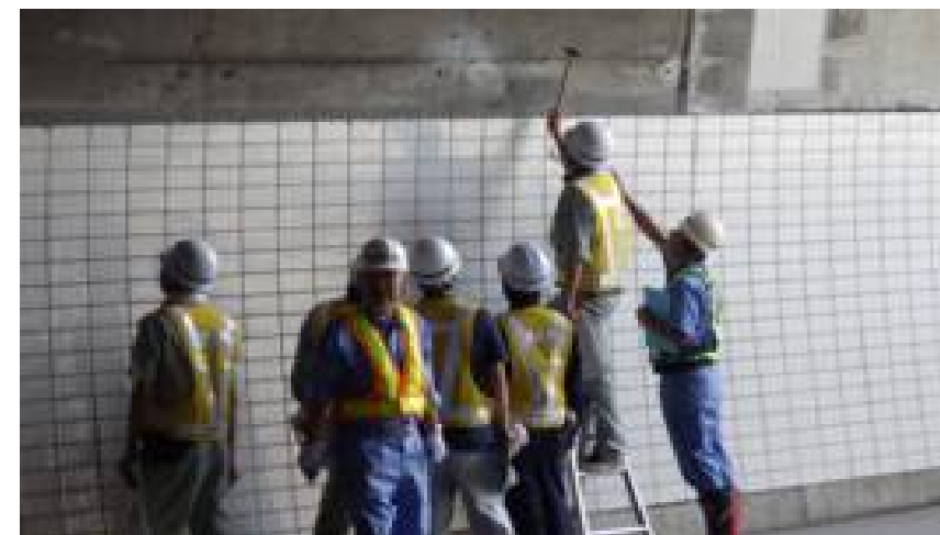
現地実習状況（H28トンネル初級）
