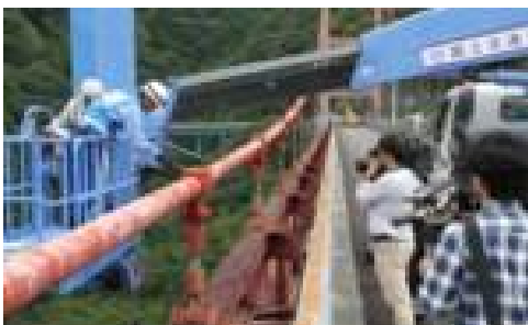
【メインケーブルの近接目視】
