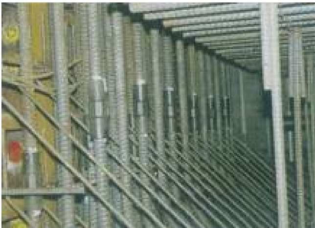
地下構造物施工例
