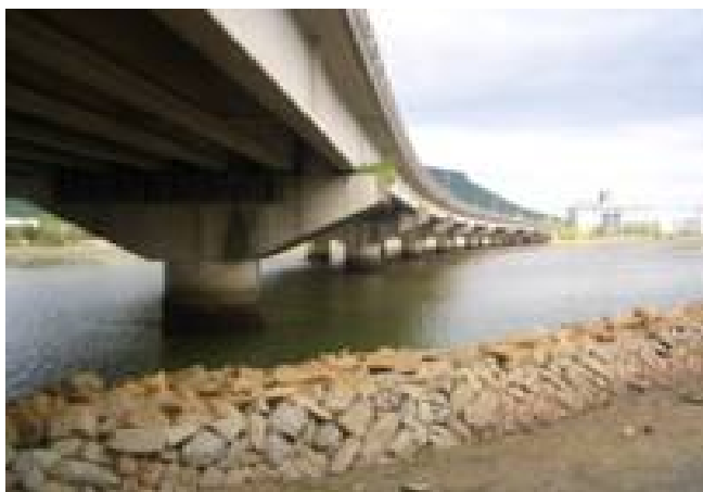
▲屋島大橋（完成後32年経過）
