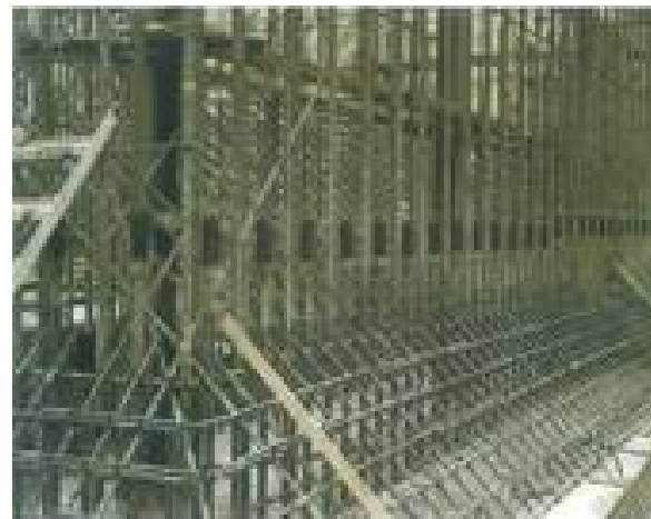
地下構造物施工例
