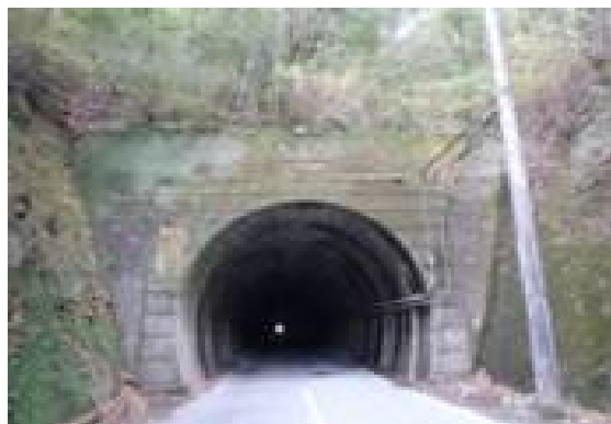
▲松尾隧道（完成後63年経過）
