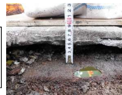
橋面舗装の状況
