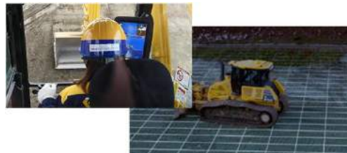
ICT建機による施工
