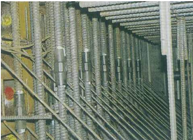
地下構造物施工例
