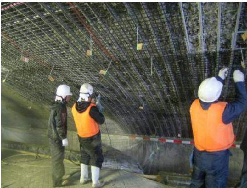
FRPグリッド設置
