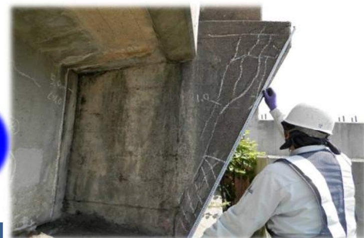
定期点検結果に基づき損傷原因に関する所見をまとめ、対策区分を判定し、補修等の計画を策定
