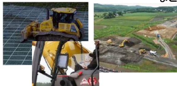
ICT建機での施工
