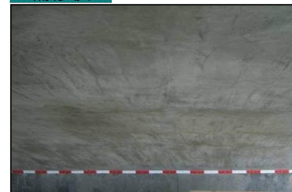
劣化部分撤去、補強、 ポリマーセメントモルタル吹付け
