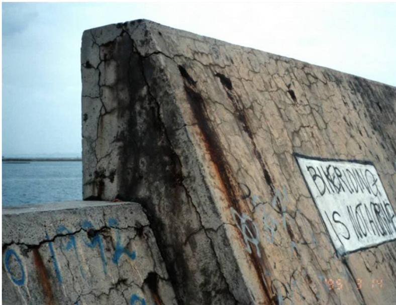
鉄筋の拘束でひび割れ大
